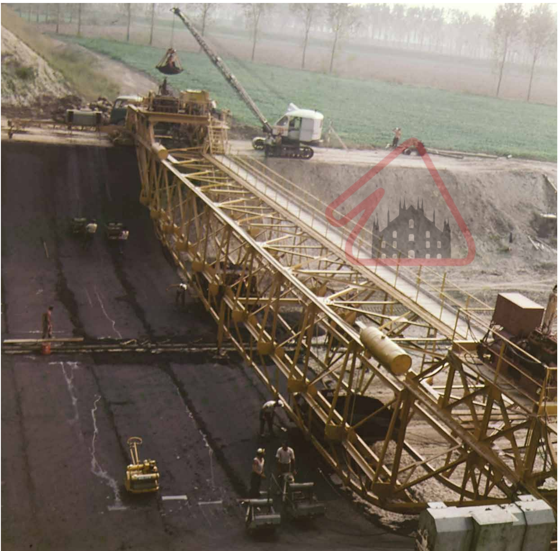
Primo tronco del canale Cremona-Spinadesco. Veduta del carro-ponte e del rivestimento bituminoso dell’alveo, autore n. id., 1966, diapositiva, (60x60 mm) ASM, Fondo Consorzio del canale Milano-Cremona-Po.
