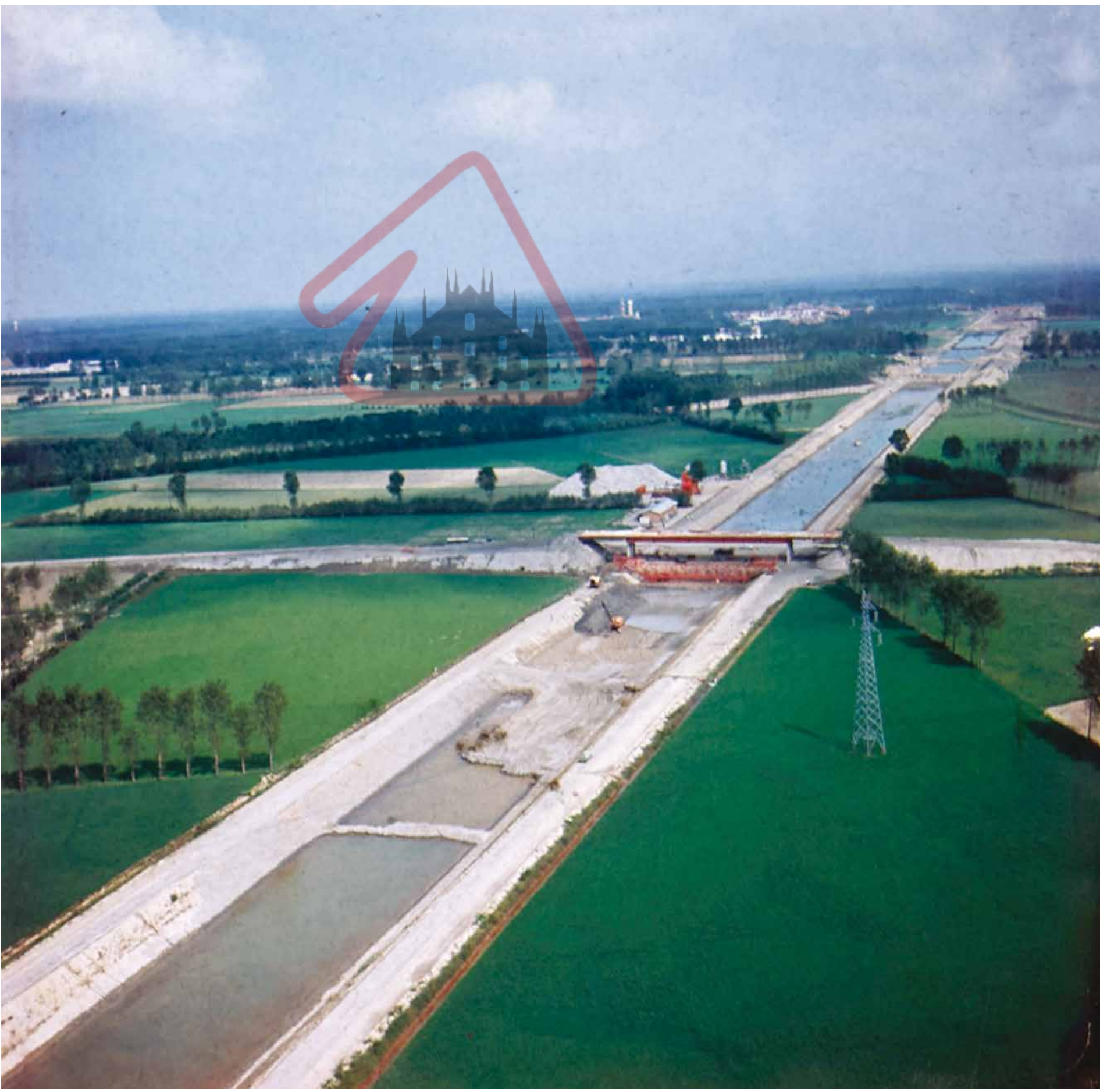
Primo tronco del canale Cremona-Spinadesco. Veduta aerea d’insieme (1966), autore n. id., diapositiva (60x60 mm). ASM, Fondo Consorzio del canale Milano-Cremona-Po.
