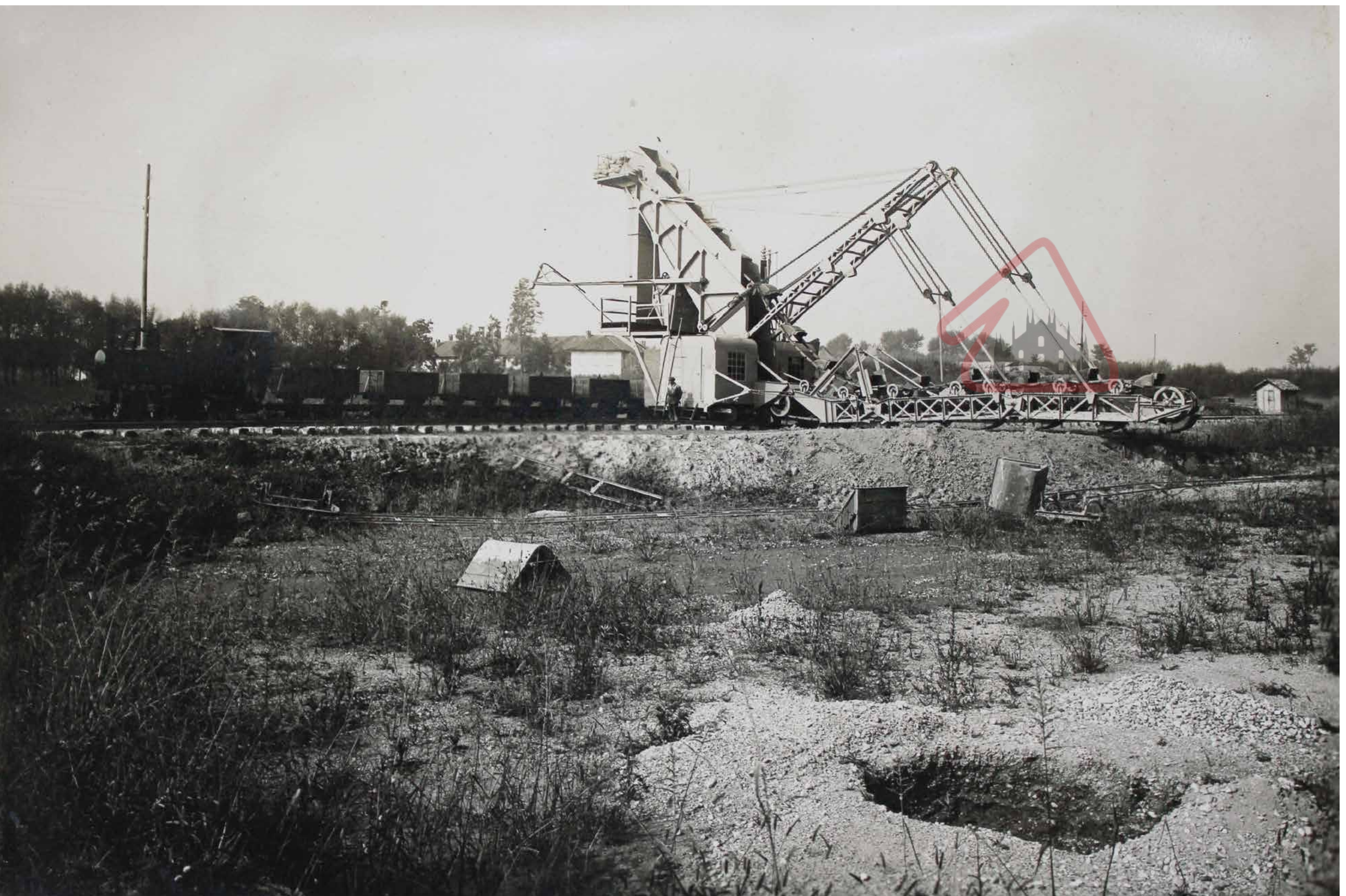
Inizio dei lavori del porto di Milano, maggio 1919. Escavatore a secchie, autore n. id., stampa ai sali d'argento (110x170 mm). MSN, Milano, Fondo Codara.
