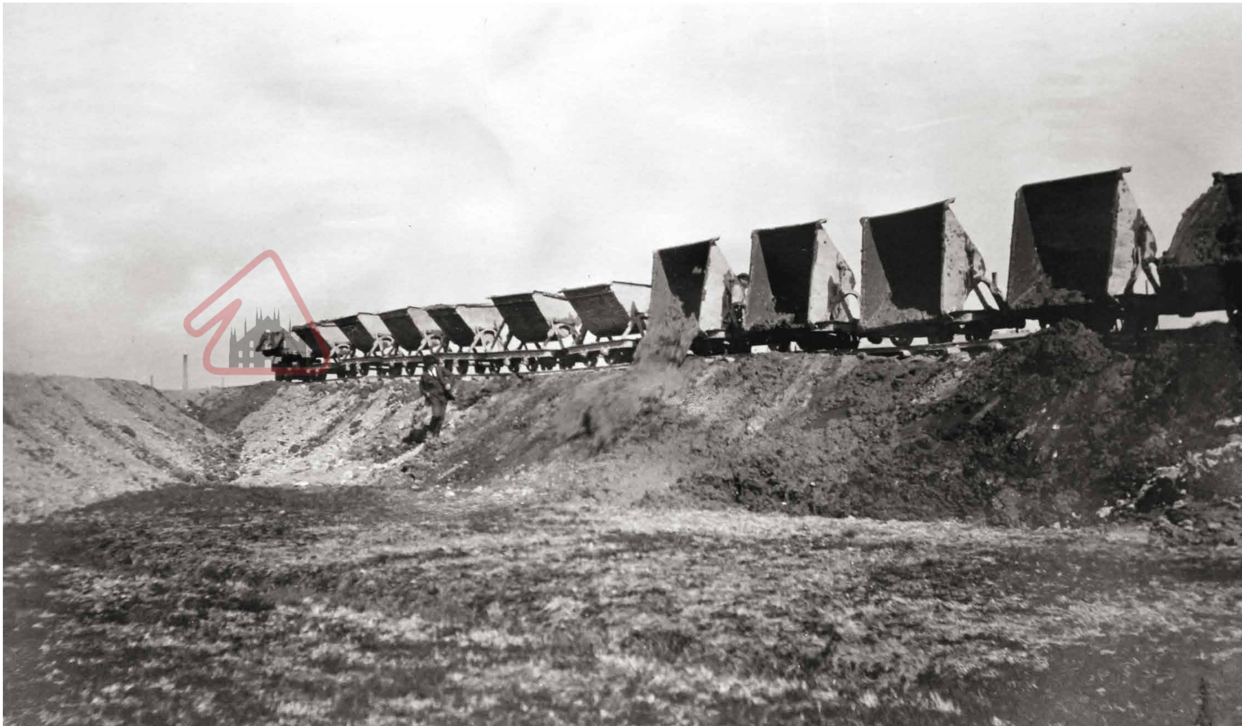
Cantiere del porto di Milano. Decauville, autore n. id, ca. 1919-1920, stampa ai sali d'argento (80x130 mm). MSN, Milano, Fondo Codara.
