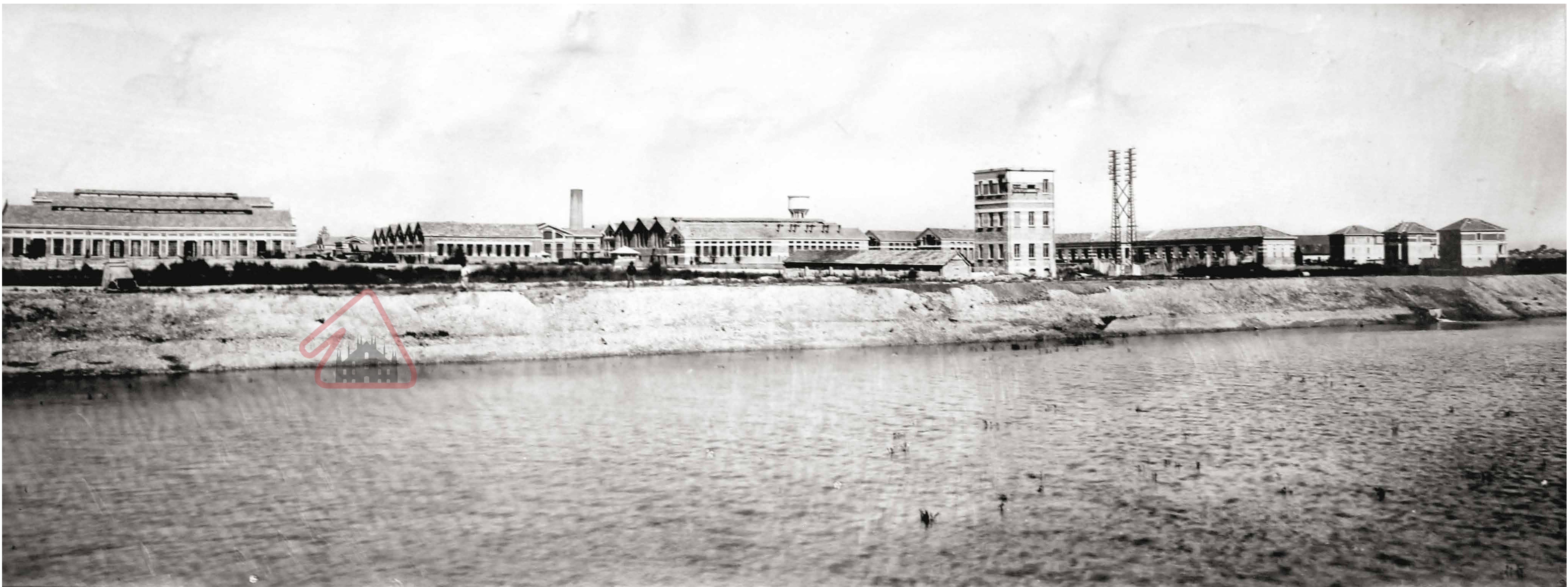
“Aquila”, fabbrica di acido citrico costruita sulla banchina del porto industriale, autore n. id., ca. 1922, stampa ai sali d’argento (95x240 mm). MSN, Milano, Fondo Codara.
