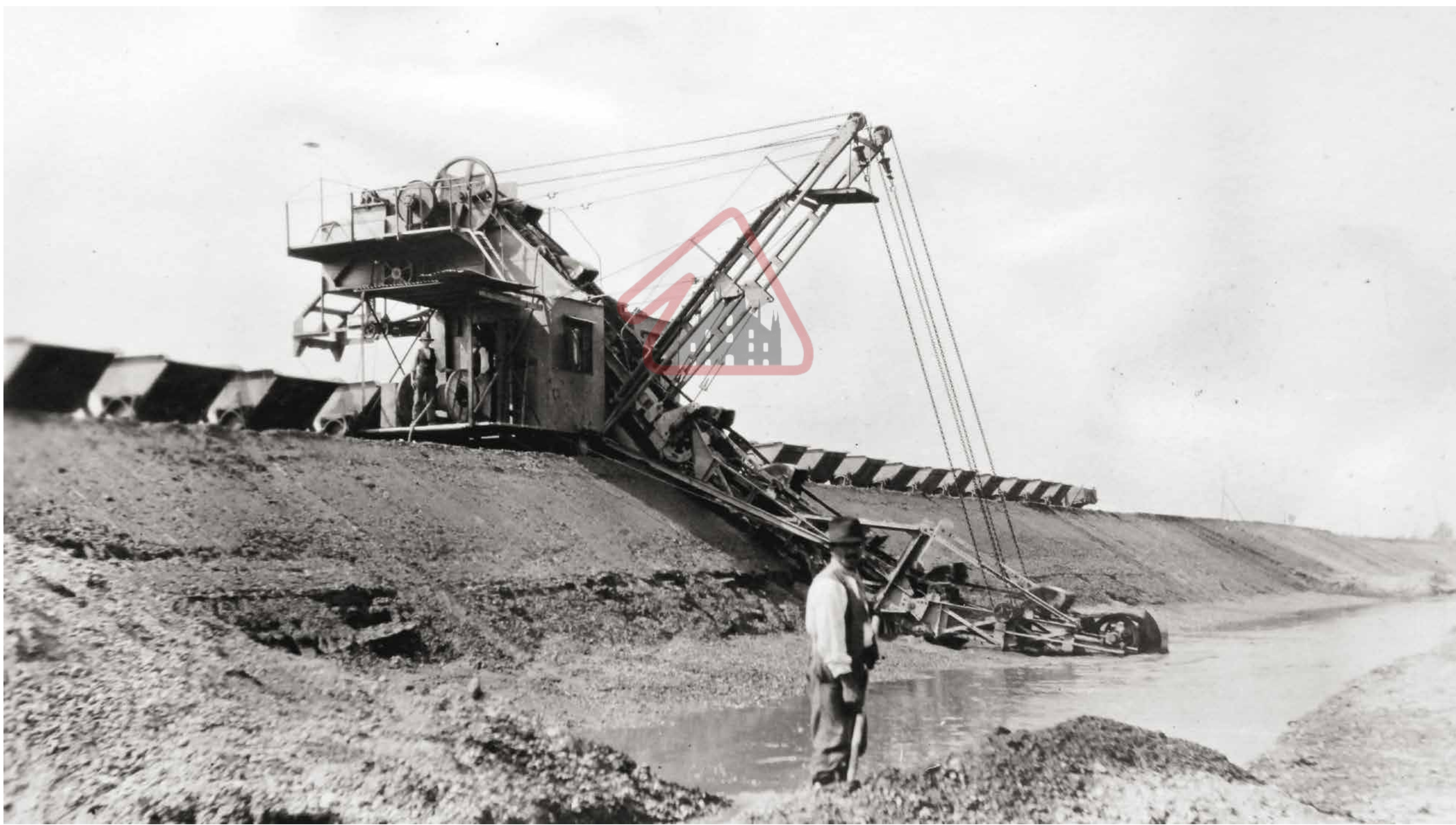
Cantiere del porto di Milano. Escavatore a secchie, autore n. id., ca. 1919-1920, stampa ai sali d'argento (80x135 mm). MSN, Milano, Fondo Codara.
