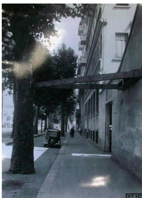
fig. 14: Italo Pacchioni, Muro cadente dell'officina Allocchio Bacchini &C. di via Sempione 93 puntellato contro un platano , Milano 23 giugno 1936, gelatina bromuro d'argento su carta, 180x240 mm., n. inv. XP697.
