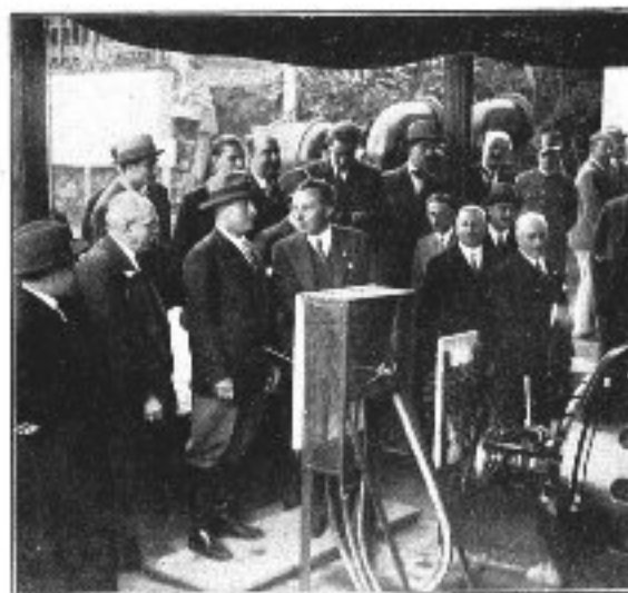
Fig. 20a — Il Duce mette in marcia l'impianto idrovoro (Fot. Luxe)
