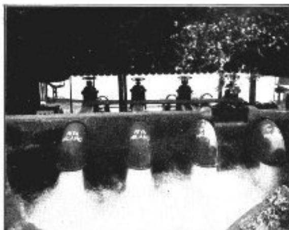
Fig. 21a — L'impianto idrovoro in funzione
