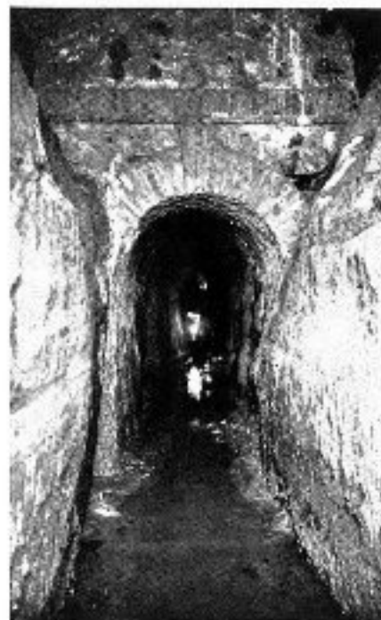
Fig. 15 - Tratti della galleria ricostruiti
