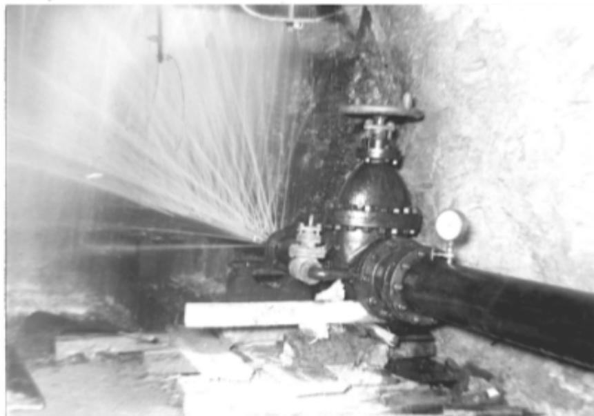
Fig. 4. — Iniettore d'acqua per la ventilazione e per il raffreddamento dell'aria.
