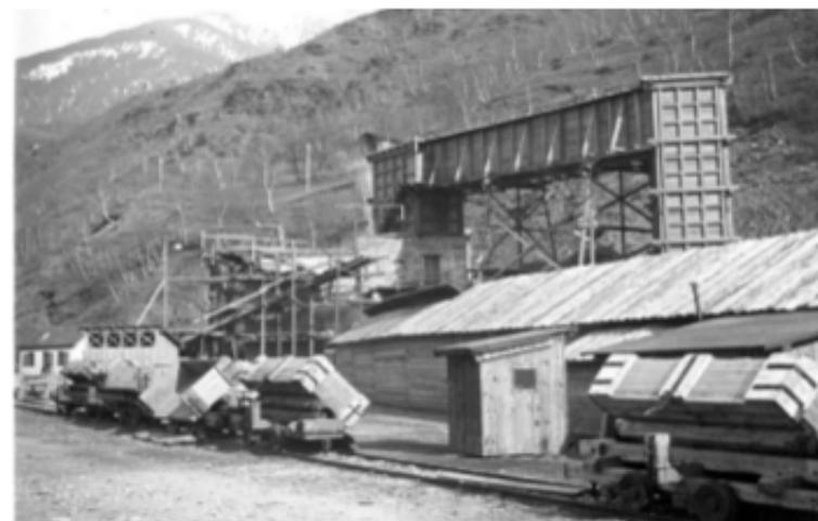
5. Impianto di ventilazione forzata al portale di Briga. Foto dottor Leone Soldati, Archivio famiglia Confalonieri-Crosti, Milano. Si distingue il condotto di ventilazione forzata, con alla base il capannone delle turbine.
