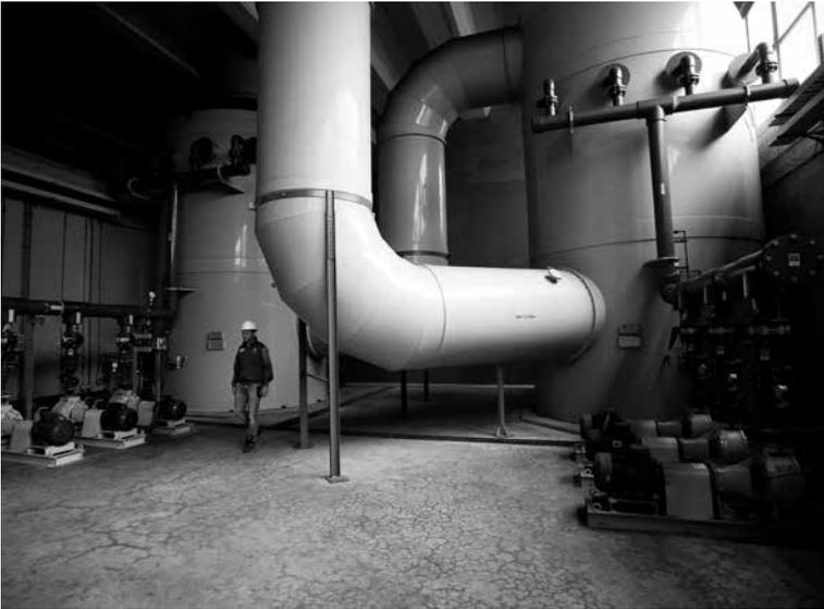
4. Particolare dell'impianto di deodorizzazione. Foto Polifemo. Cortesia MM Spa. I processi che possono provocare esalazioni maleodoranti si svolgono in ambienti chiusi da cui l'aria viene aspirata e deodorizzata in un impianto centralizzato.
