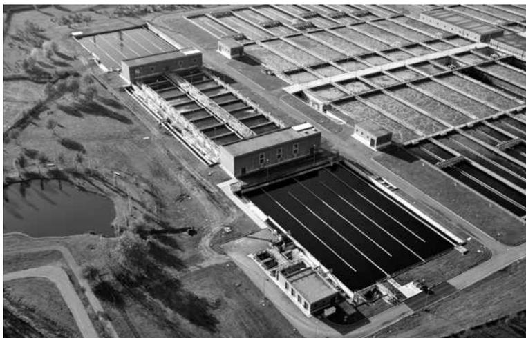
6. Depuratore di Milano Nosedo, dettaglio delle fasi finali di filtrazione e disinfezione acque. Sono riconoscibili le tipiche vasche a *chicane*, che garantiscono il corretto tempo di contatto tra acqua depurata e prodotto disinfettante prima della reimmissione in ambiente esterno, foto MilanoDepur S.p.a.
