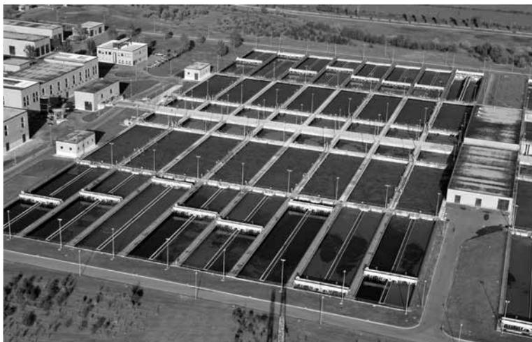
5. Depuratore di Milano Nosedo, dettaglio della zona di trattamento biologico. Nella parte centrale dell'immagine sono visibili le vasche a fanghi attivi e, sui lati esterni di ciascuna linea, le vasche di sedimentazione, foto MilanoDepur S.p.a.
