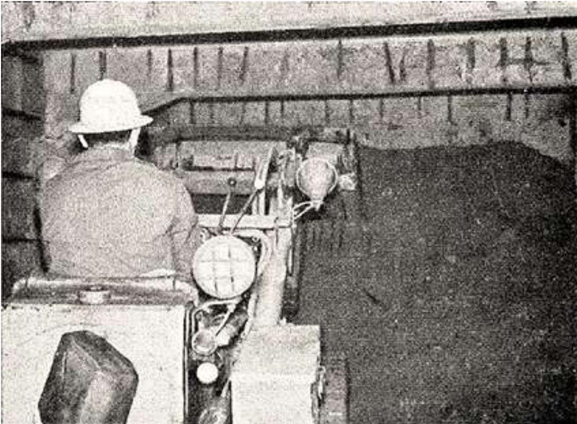
17. Livellamento e costipazione del primo strato di riempimento del canale. Da A. Gentile, *L'ammaloramento delle strutture della Fossa interna...*, "Rivista italiana di geotecnica", 1972, n. 2.
