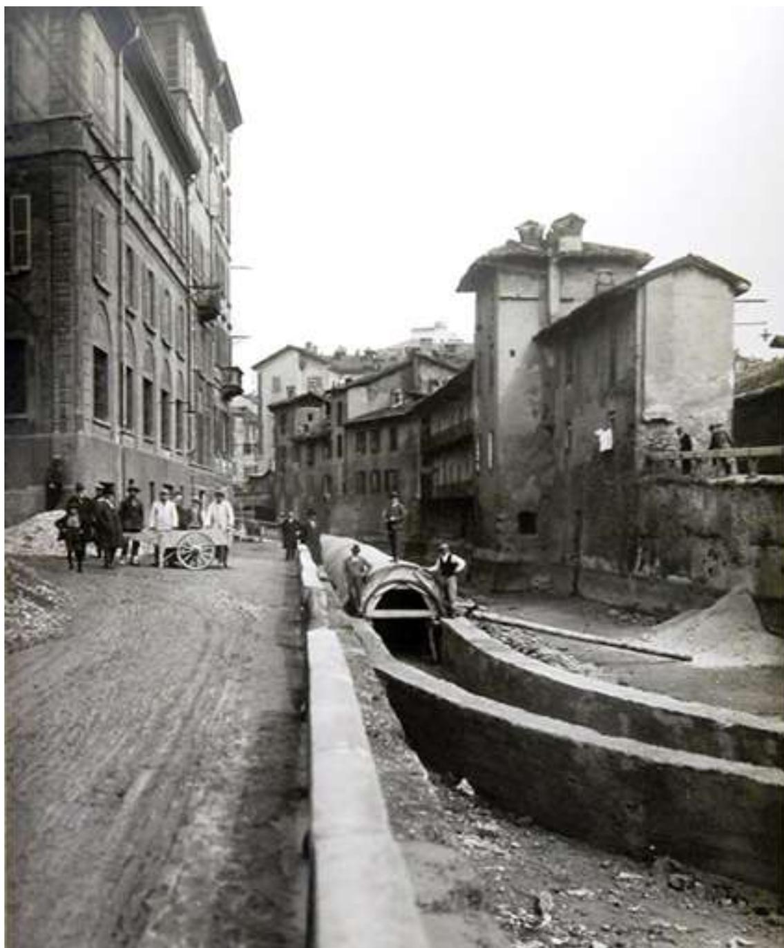
7. 1929. Interramento del Naviglio del Vallone, particolare della costruzione del condotto per il collegamento idraulico con la Darsena. Archivio storico FCA.
