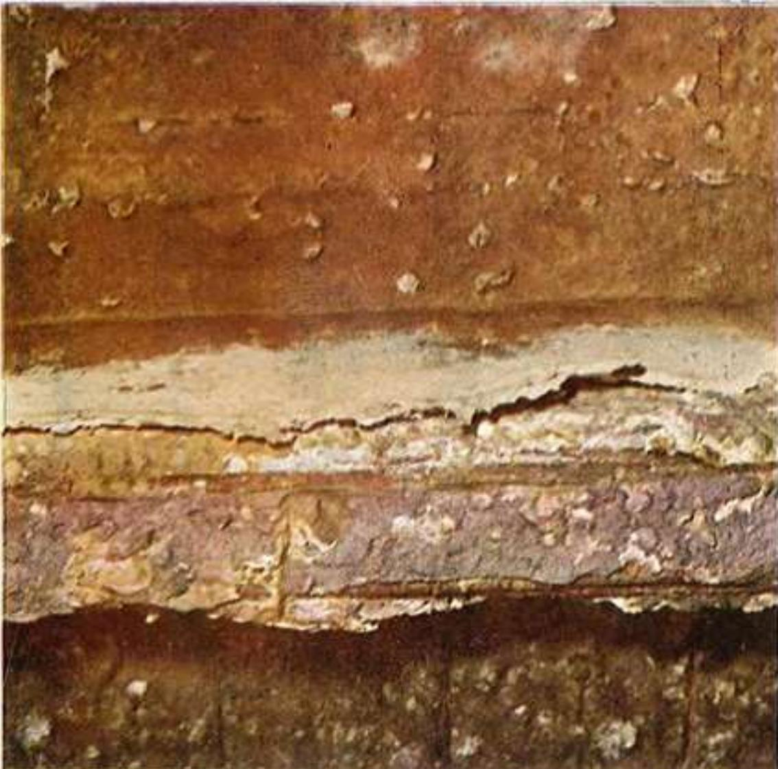
13. Fenomeni di degrado delle strutture di copertura della Fossa interna, corrosione delle barre di armatura. Da A. Gentile, *L'ammaloramento delle strutture della Fossa interna...*, "Rivista italiana di geotecnica", 1972, n. 2.
