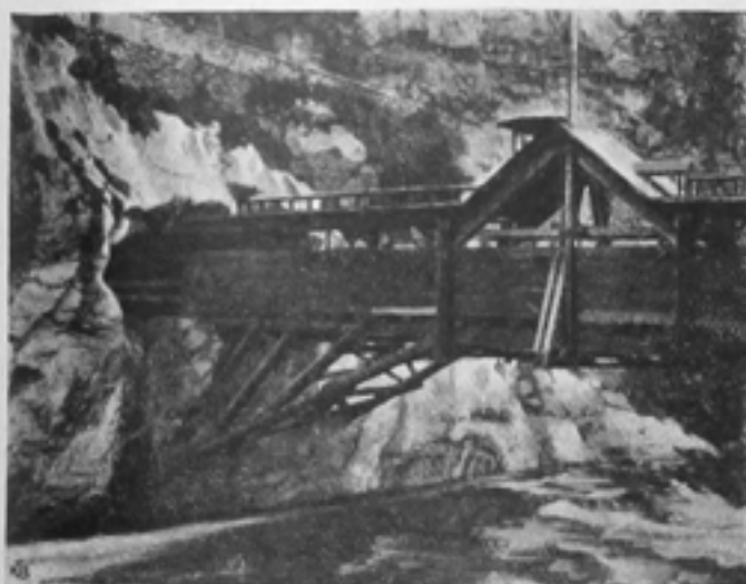
Iselle. — Galleria d'entrata al tunnel per gli operai.
