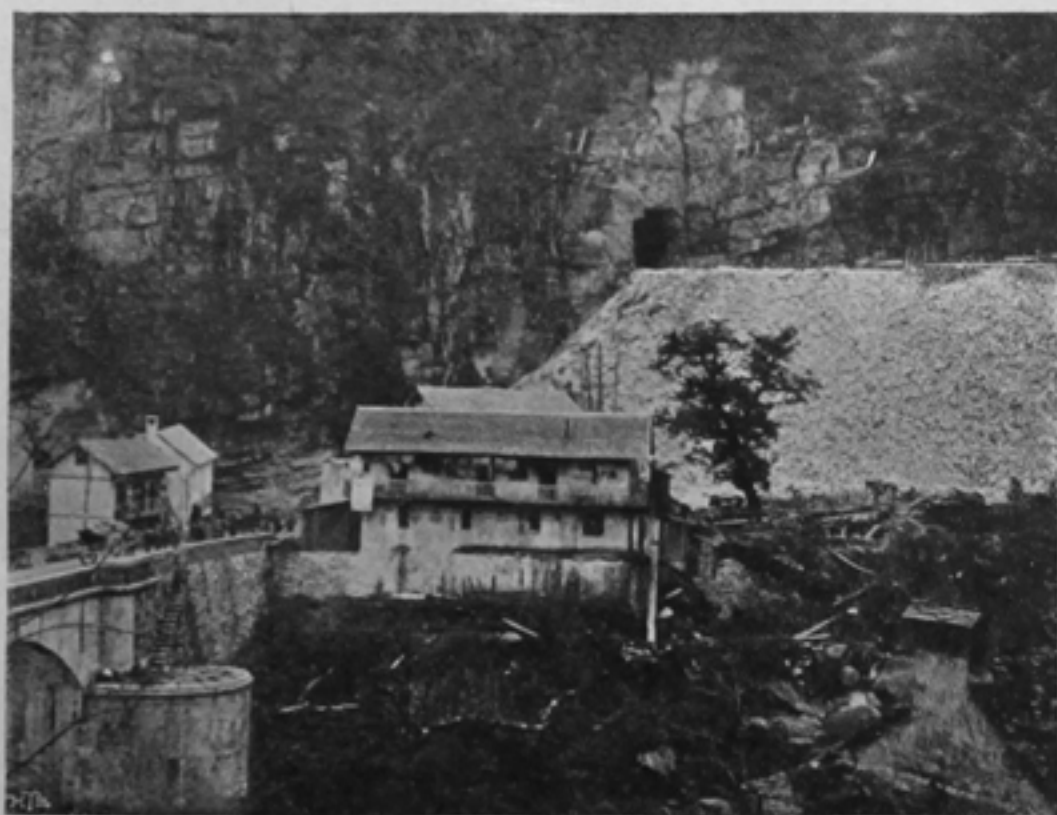
A Varzo. — Entrata del tunnel elicoidale della Mediterranea.
