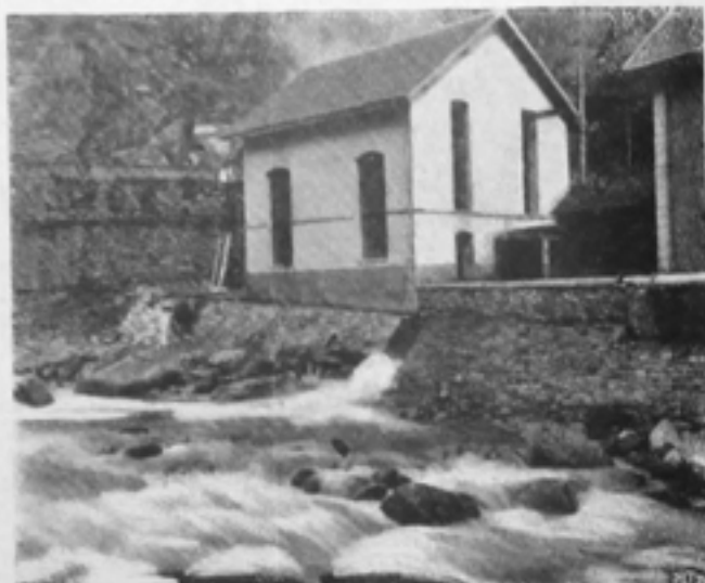
Iselle. — L'acqua che esce dal tunnel.
