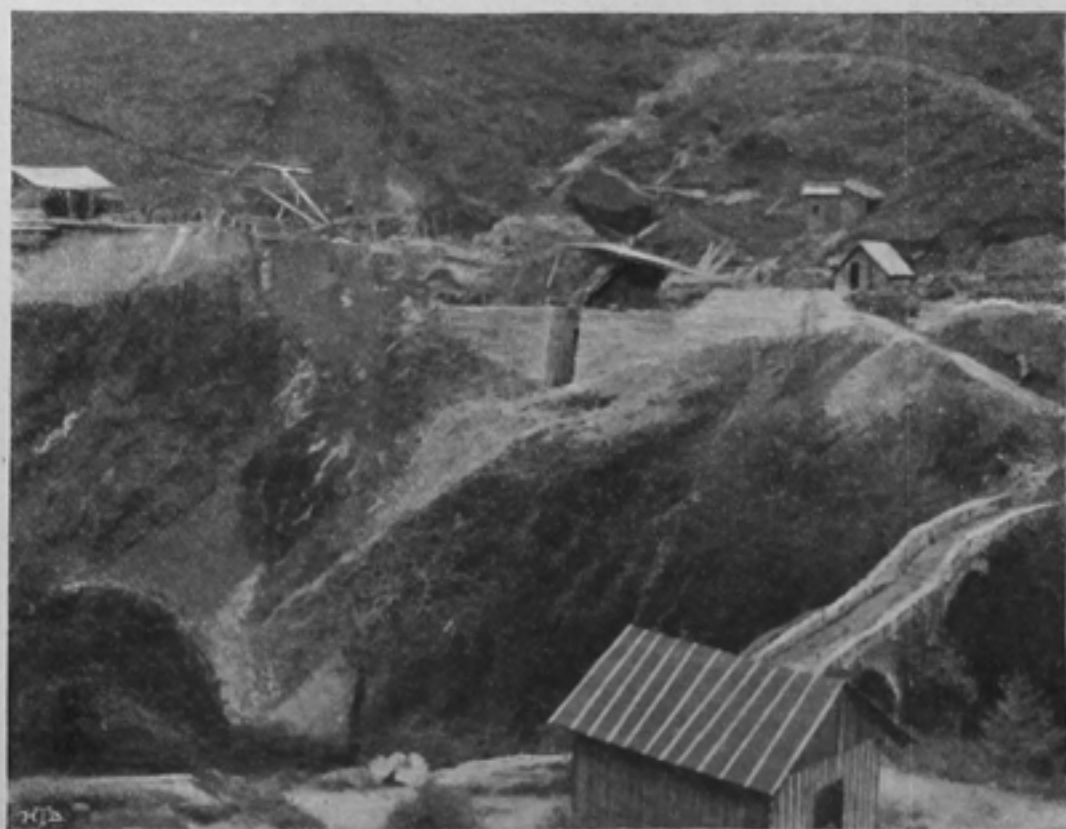
Iselle. — Lavori per la linea d'accesso.
